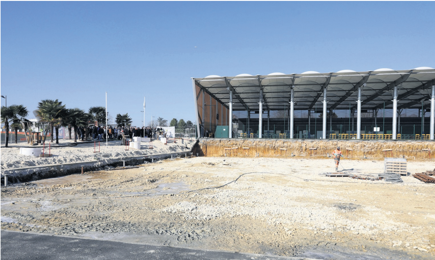
Les travaux en cours à la Plaine des sports feront de ce site une référence nationale du beach soccer. (Photo NR, Thierry Roulliaud)
